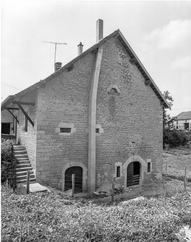
Façade latérale droite.
