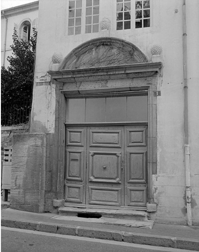
Façade sur la rue Sébile, portail gauche.
