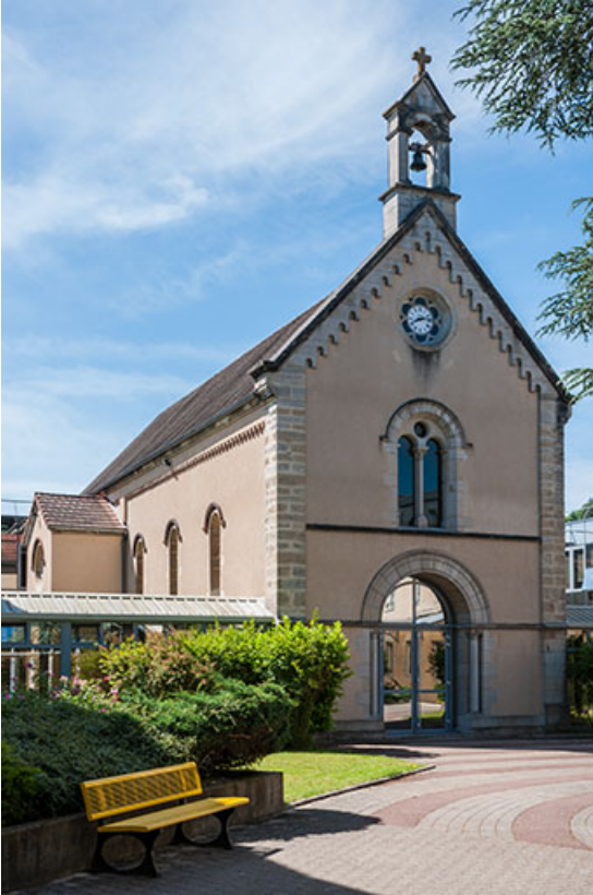
Chapelle : vue extérieure
