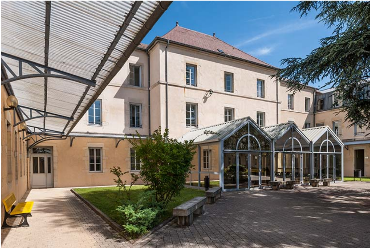
Façade postérieure du pavillon d'entrée
