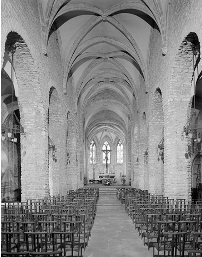
Eglise Saint-Désiré. Vaisseau central vu depuis l'ouest.
