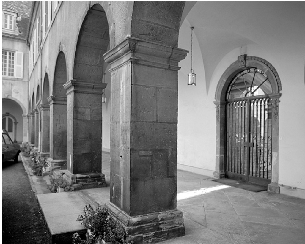
Cloître, galerie sud : porte d'accès à l'escalier.
