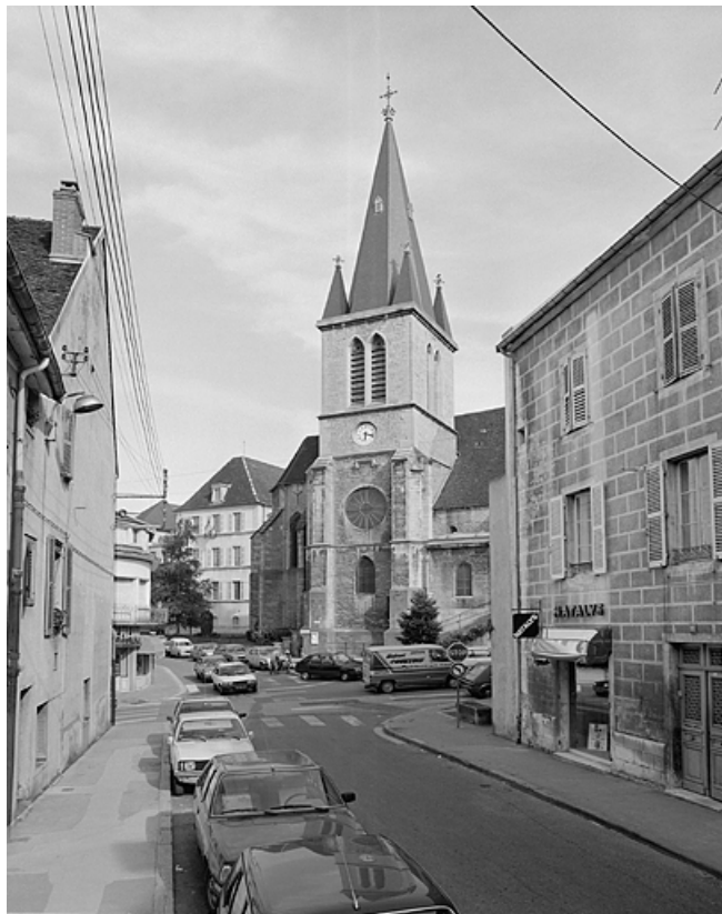
Eglise Saint-Désiré. Vue générale du clocher.
