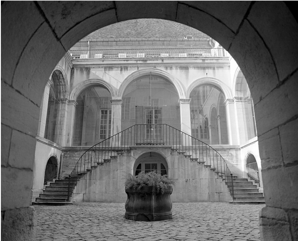
Cour intérieure, escalier : côté ouest.
