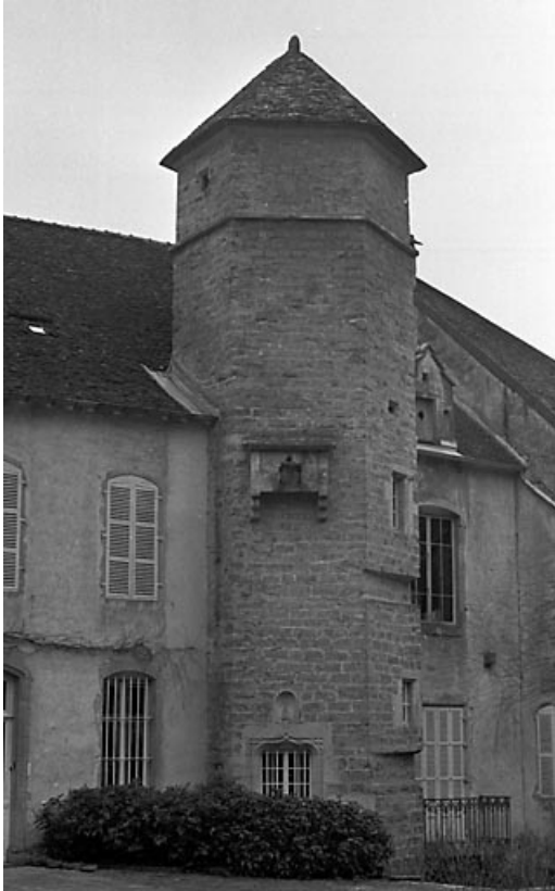
Détail de la façade antérieure.
