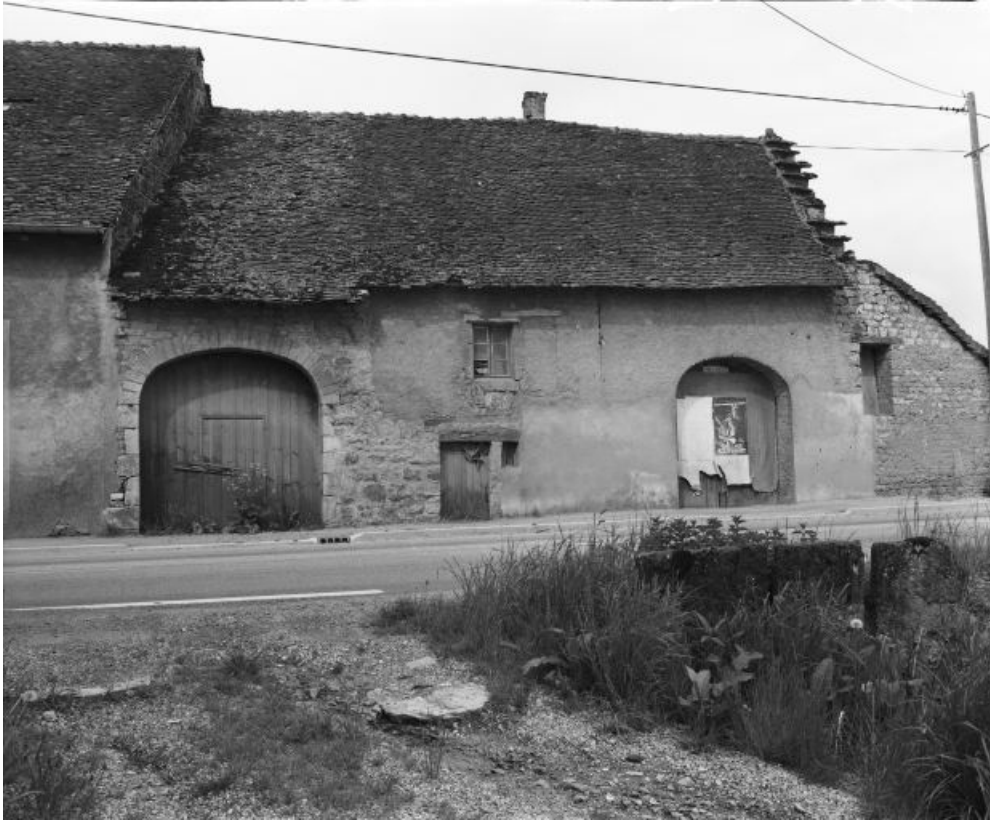
Façade antérieure vue de face.
