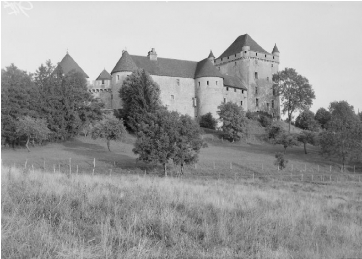
Façade ouest : vue d'ensemble.
