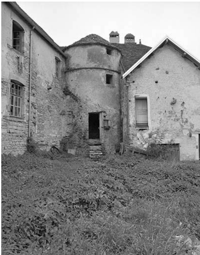
Façade ouest, partie gauche.
