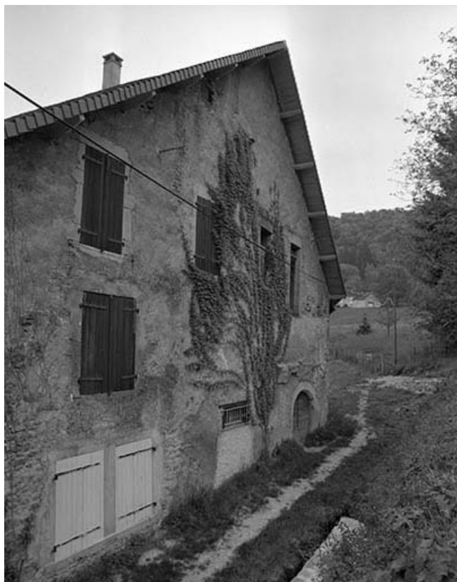
Façade latérale droite.
