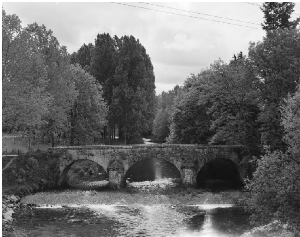
Face aval, vue de face.
