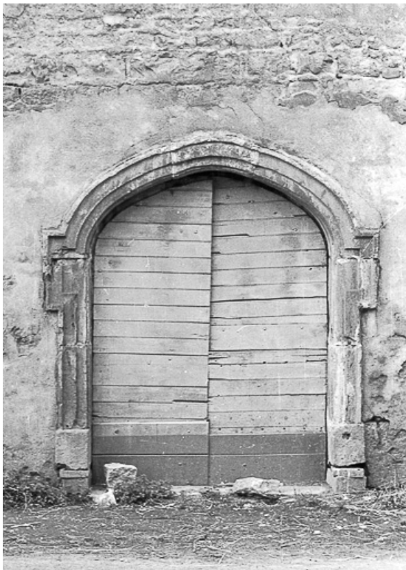
Détail d'un portail.
