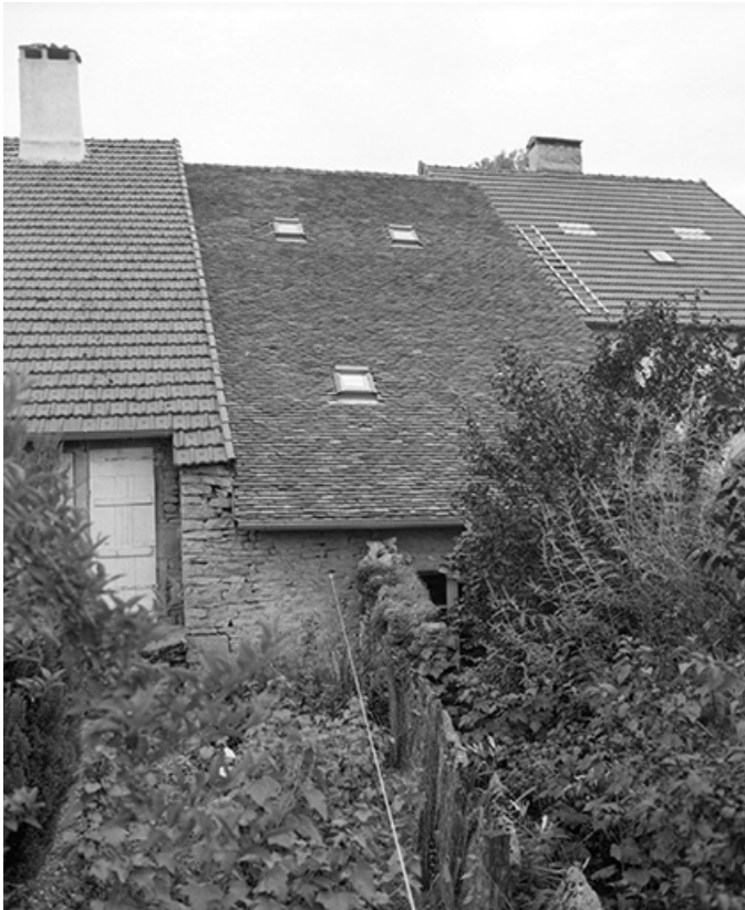
Maisons situées rue de l'Eglise : façades postérieures.
