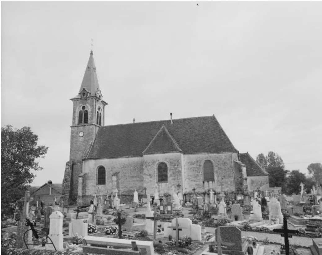
Façade latérale droite.
