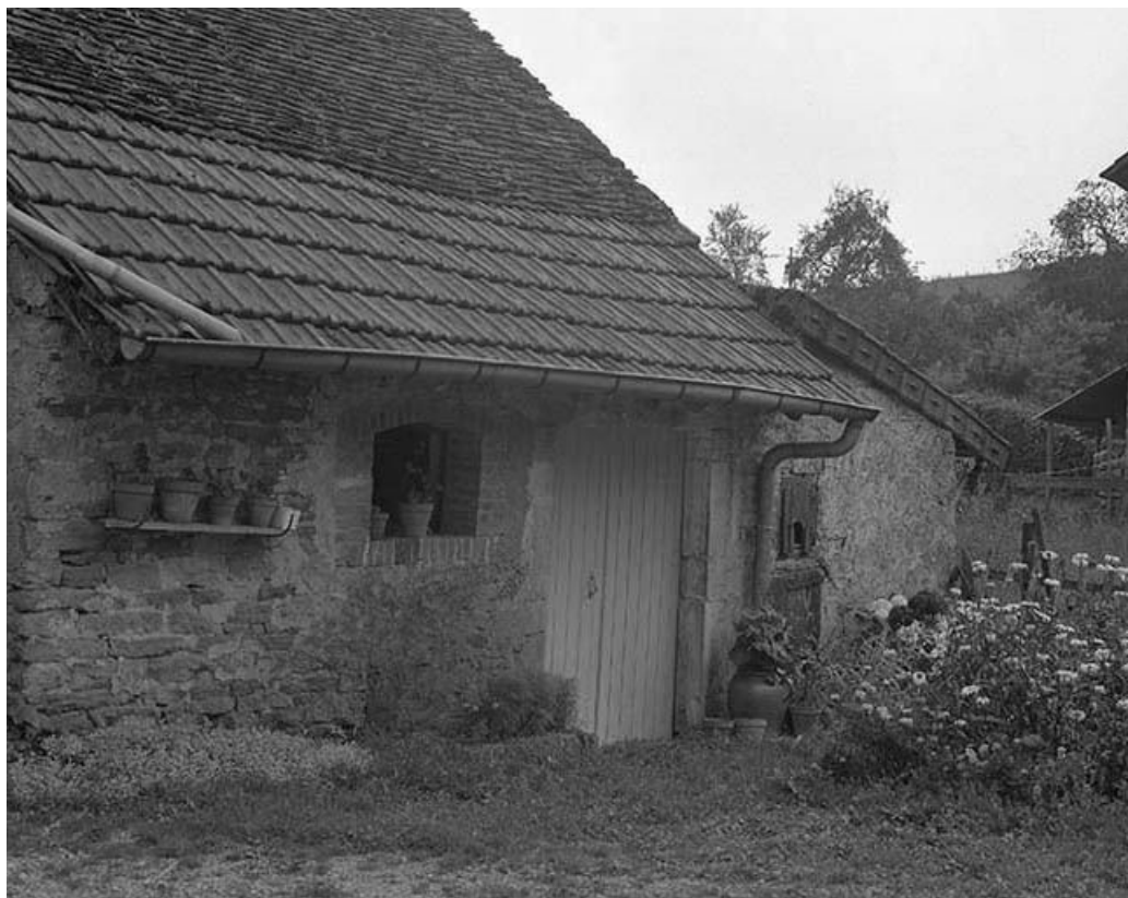
Façade antérieure : partie droite.
