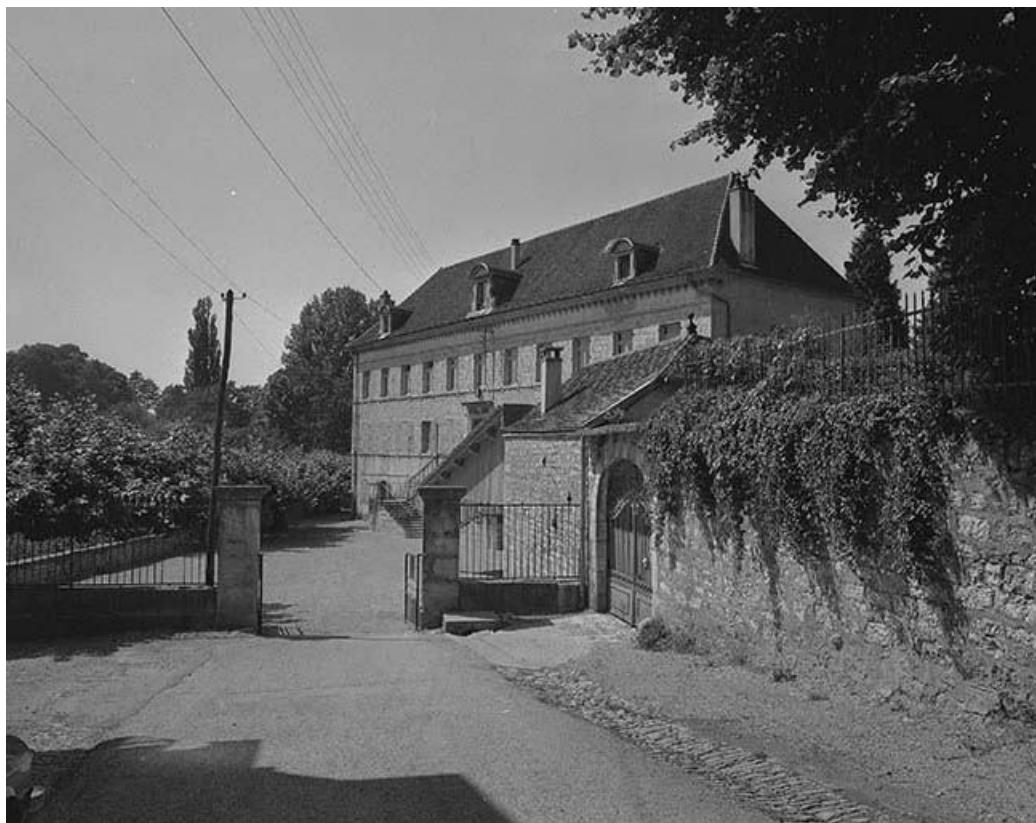
Vue générale depuis l'entrée de la cour.
