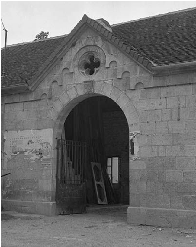
Façade est, passage d'entrée.
