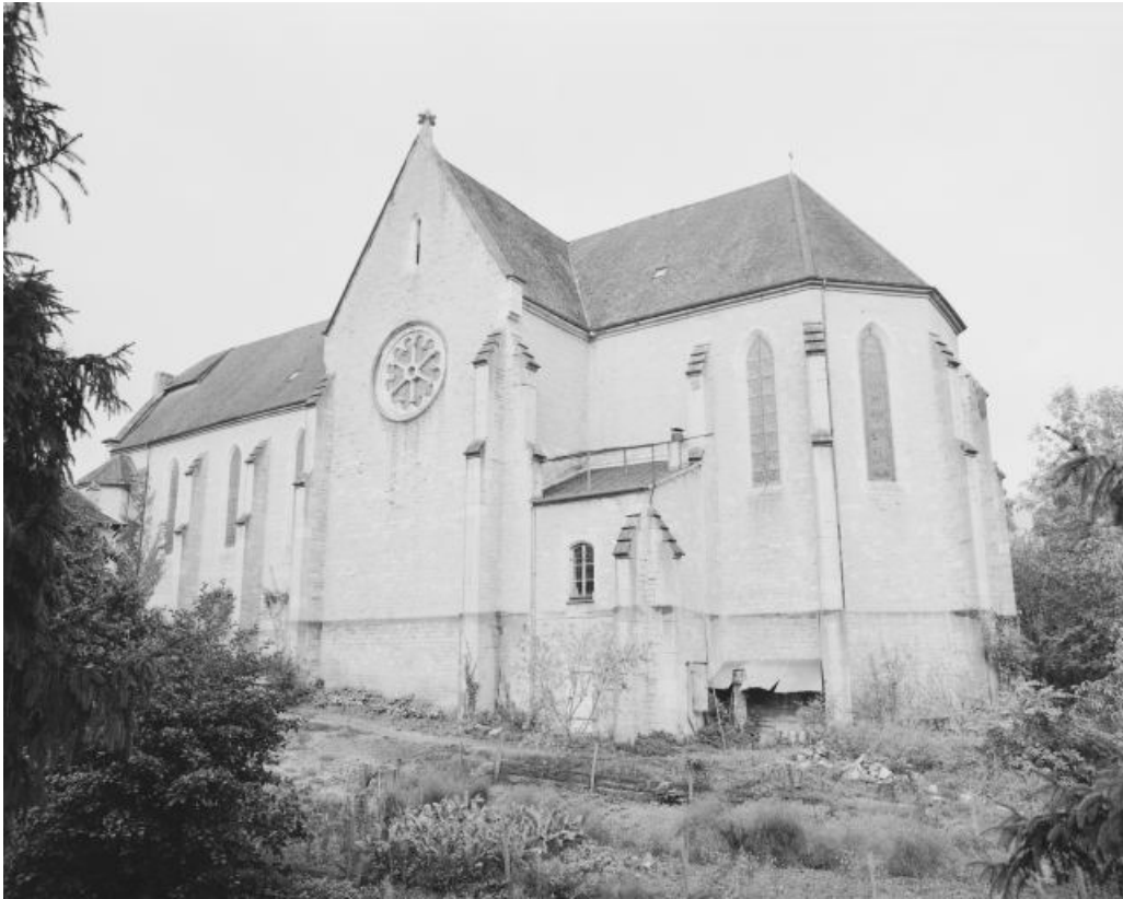
Extérieur : façade latérale droite.
