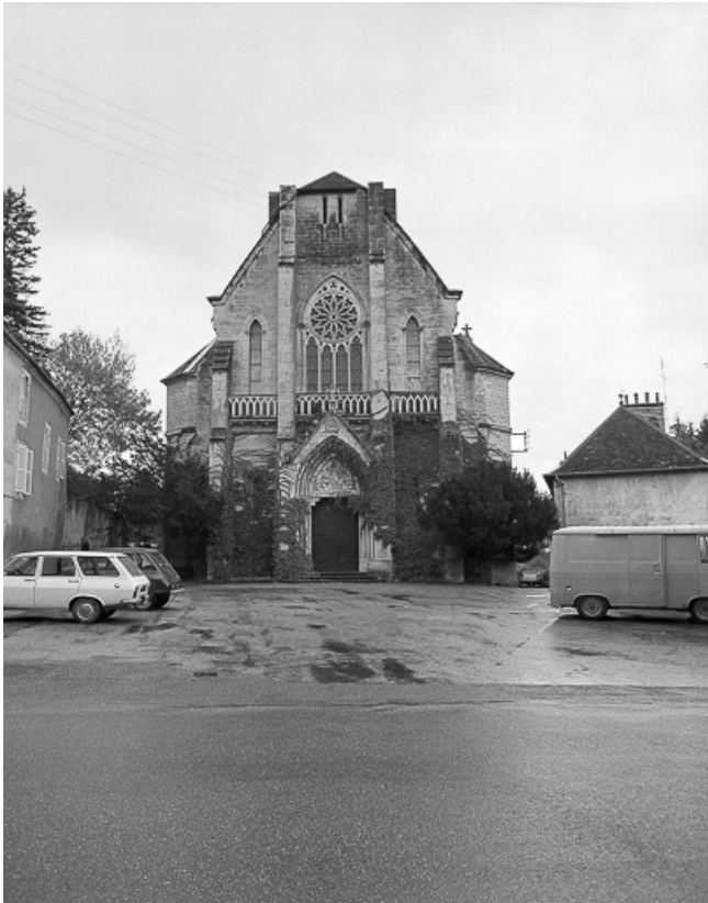
Extérieur : façade antérieure.
