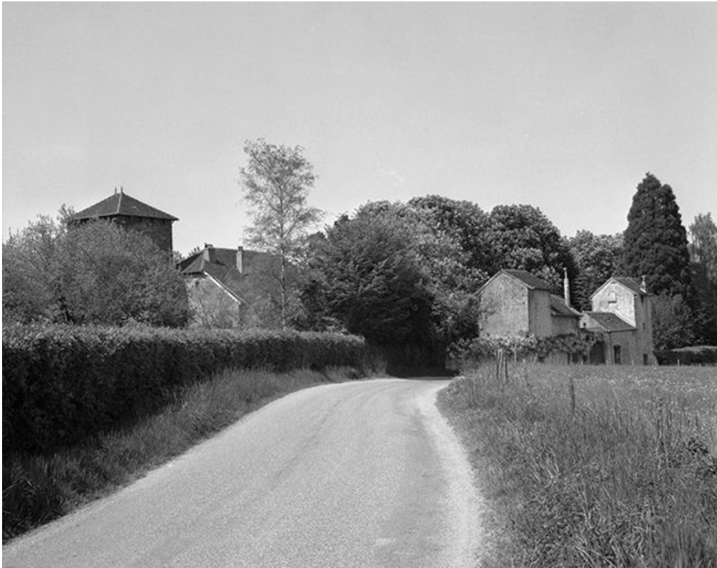
Vue générale depuis le Sud.
