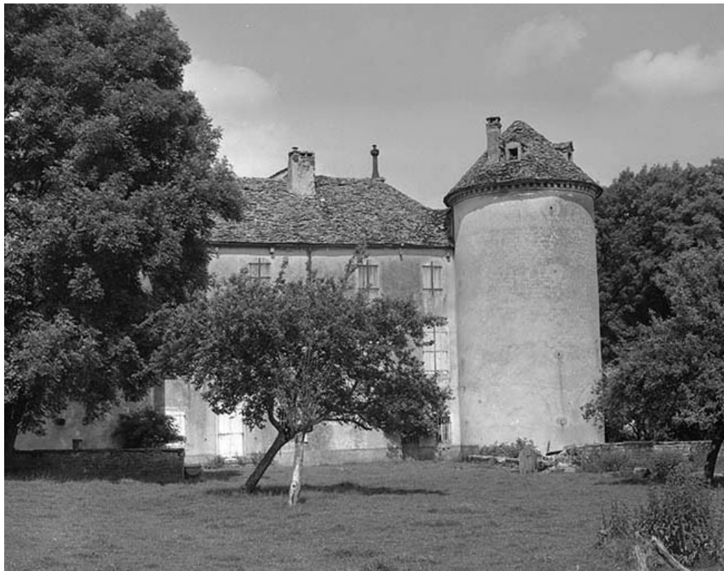
Tour de l'angle Sud-Est.
