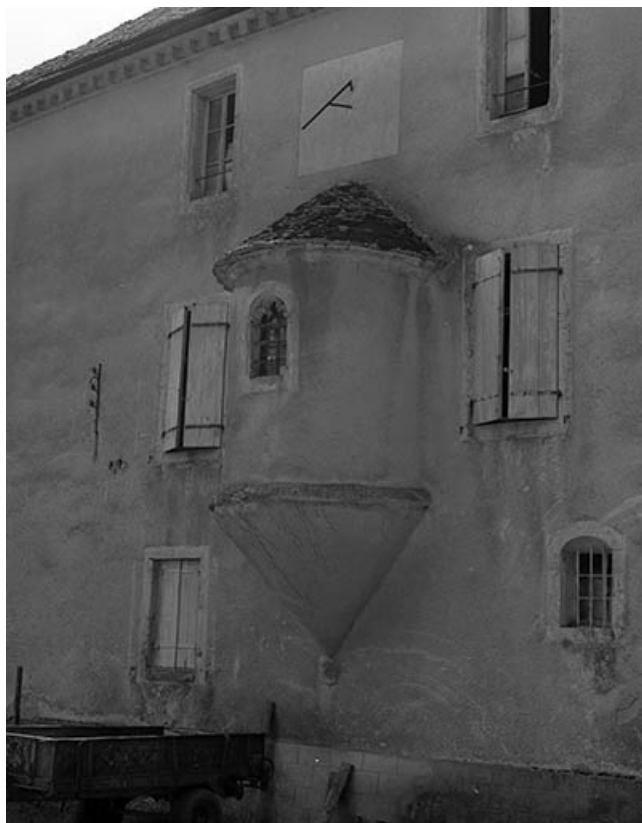
Face Est, détail : l'échauguette.
