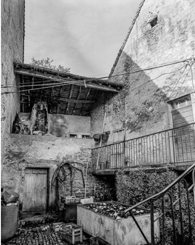
La cour entre les deux bâtiments.
