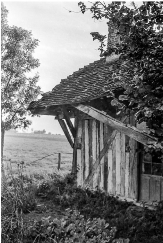
Ferme cadastrée 1956 A1 142-143 : détail du auvent. 39, Fontainebrux
