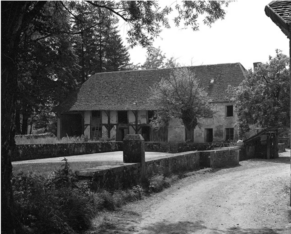
Façade antérieure du moulin.
