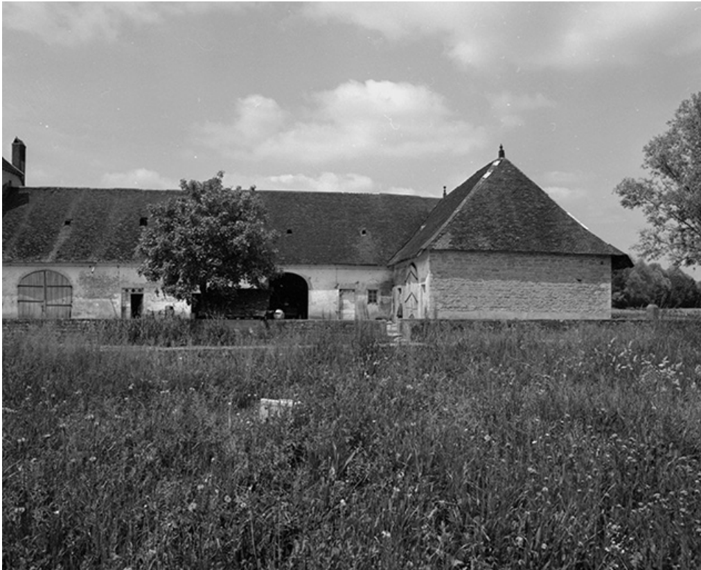
Bâtiment d'exploitation de la ferme.
