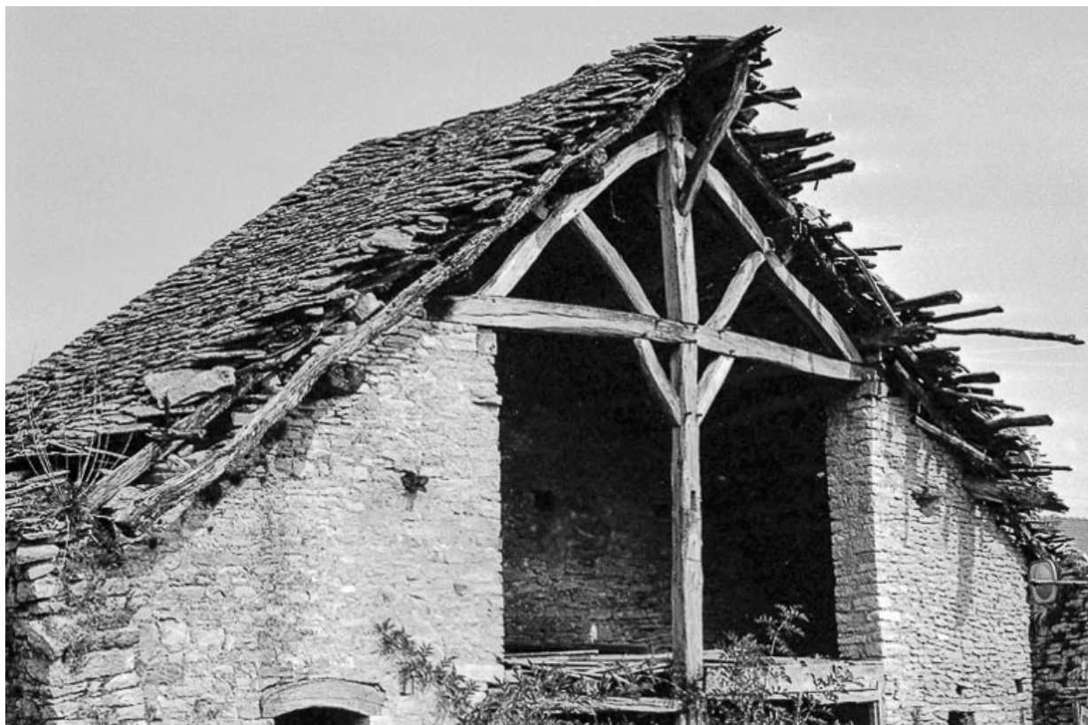
Ferme cadastrée B3 256 : toiture.
