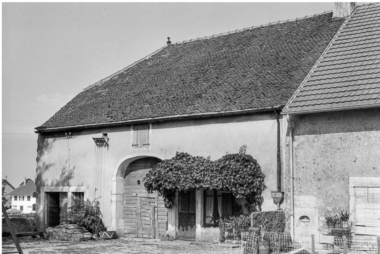
Ferme cadastrée D2 215 : façade antérieure.
