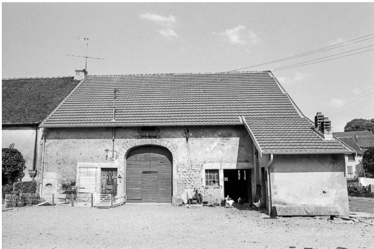
Ferme cadastrée D2 214 : façade antérieure.
