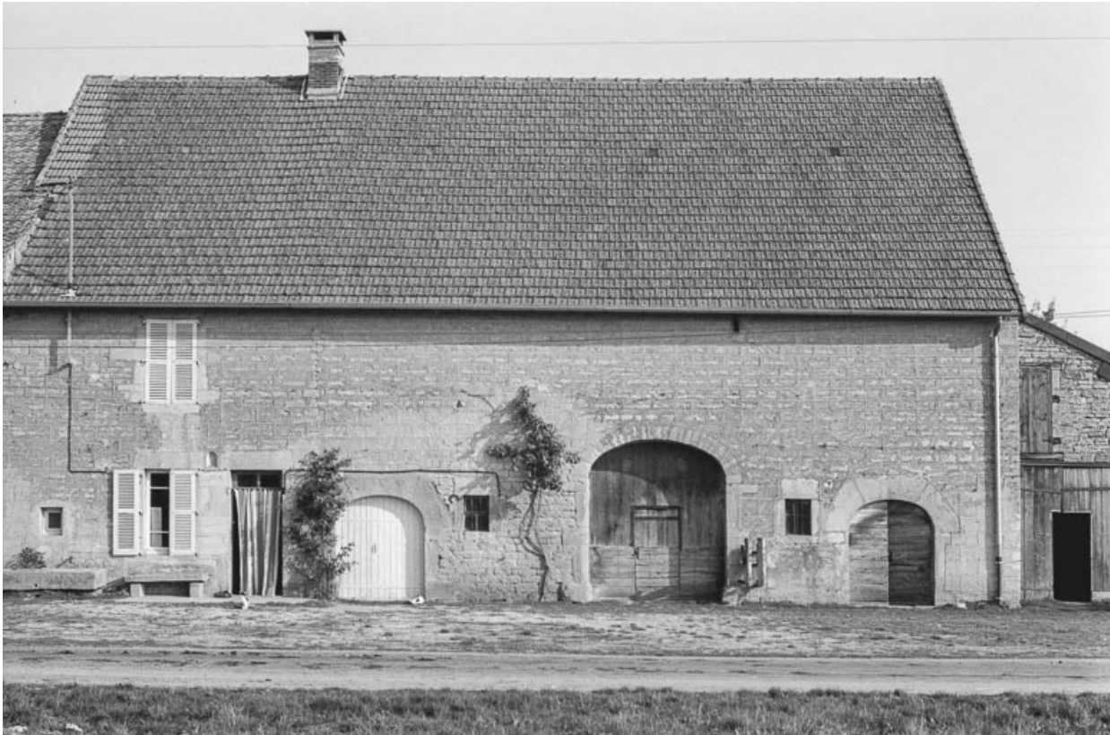
Ferme cadastrée A3 564 : façade antérieure.
