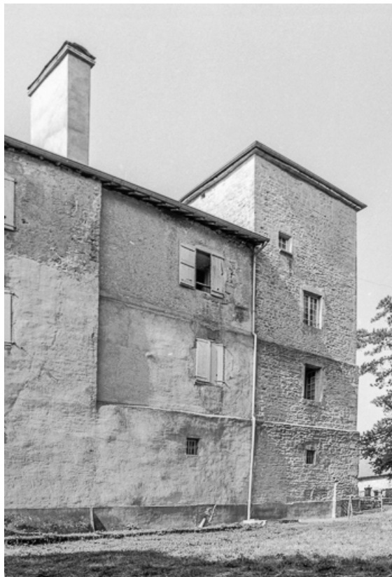
Face nord (la tour).
