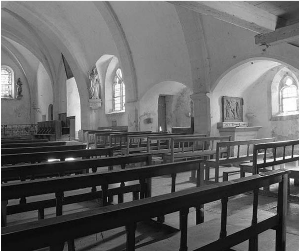
Intérieur : élévation droite vue depuis l'entrée.
