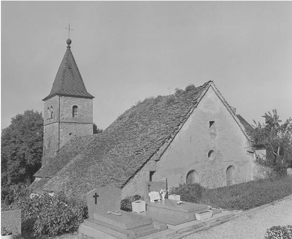
Façade latérale droite et chevet.
