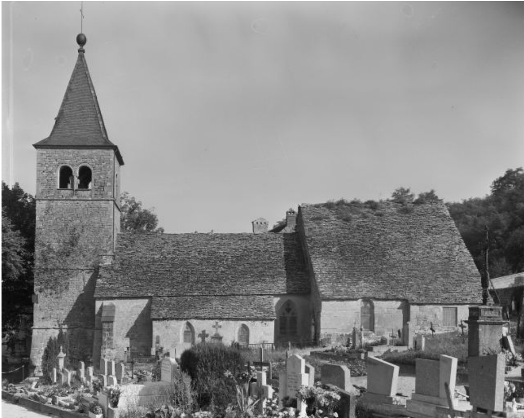
Façade latérale droite.
