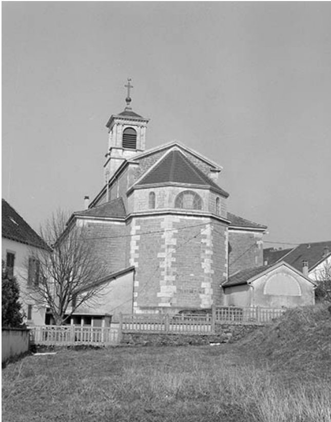
Extérieur : abside vue de trois quarts.
