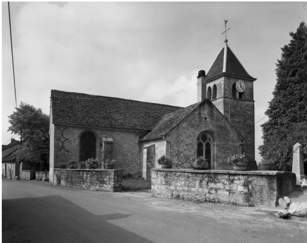
Vue d'ensemble extérieure.
