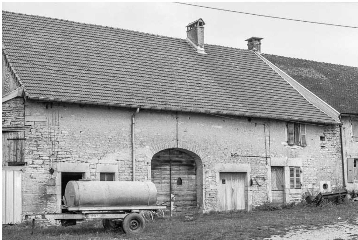
Ferme cadastrée C1 31 : façade antérieure. 39, Nogna
