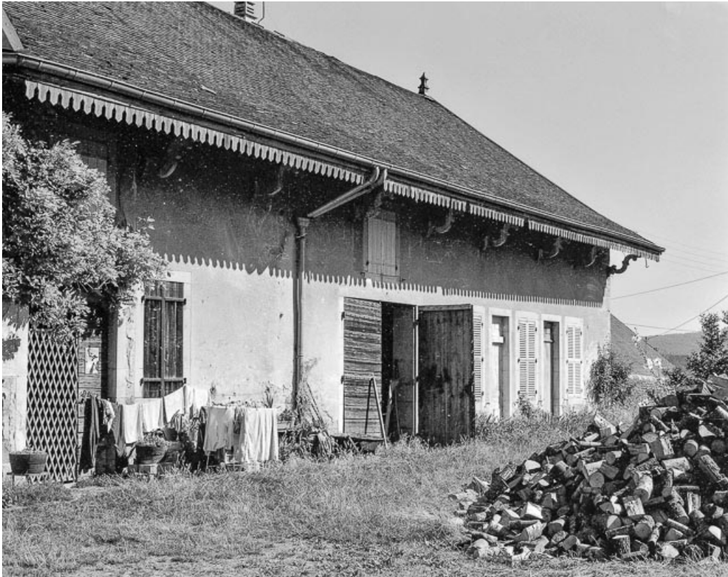
Maison cadastrée AC 251 ; façade postérieure. 39, Montaigu
