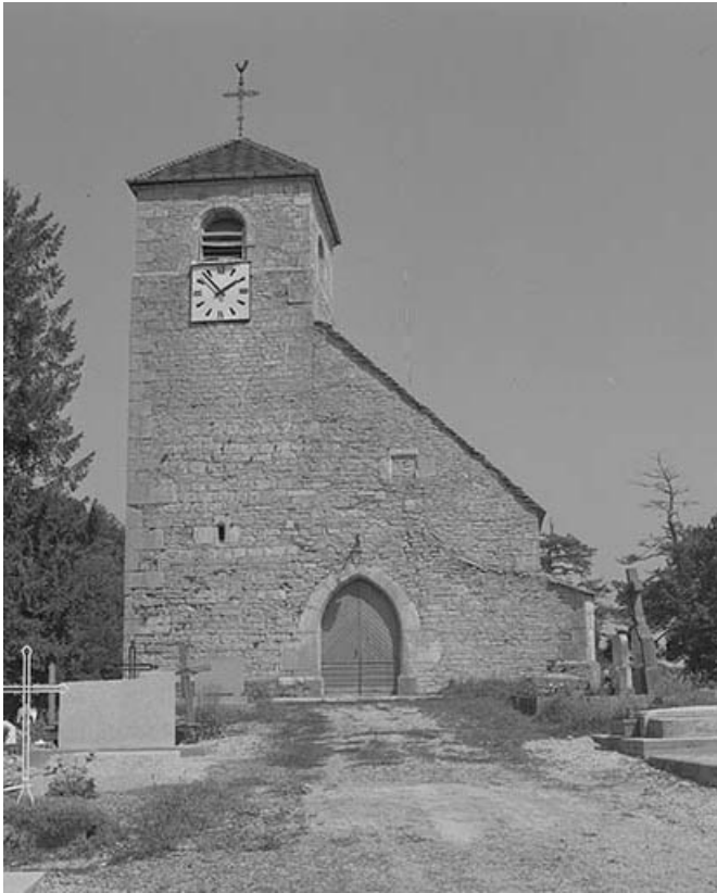
Façade antérieure vue de face.
