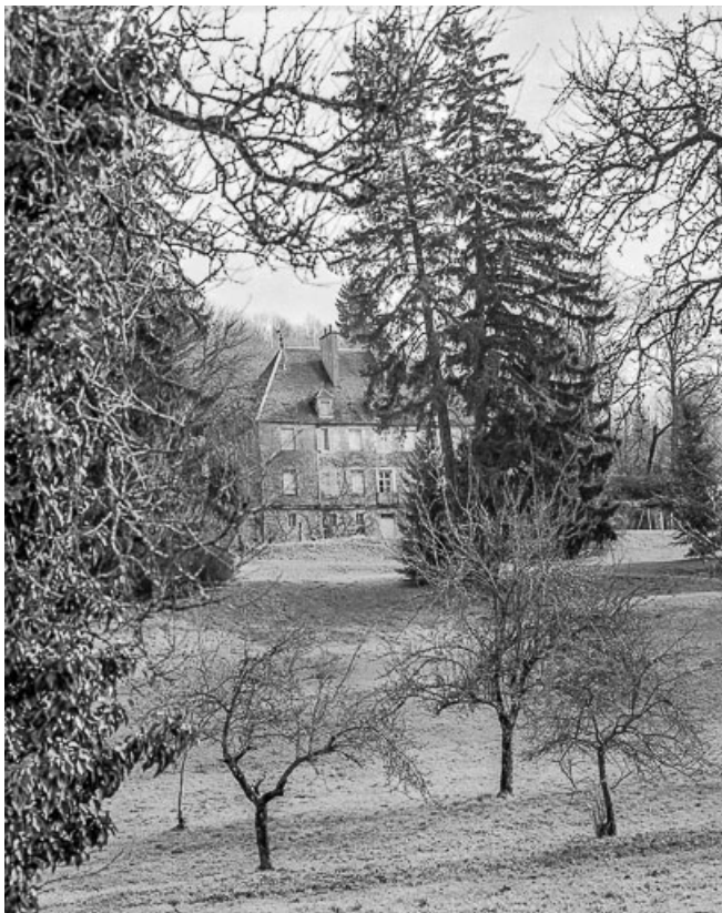
Logis : façade occidentale, parc et verger.
