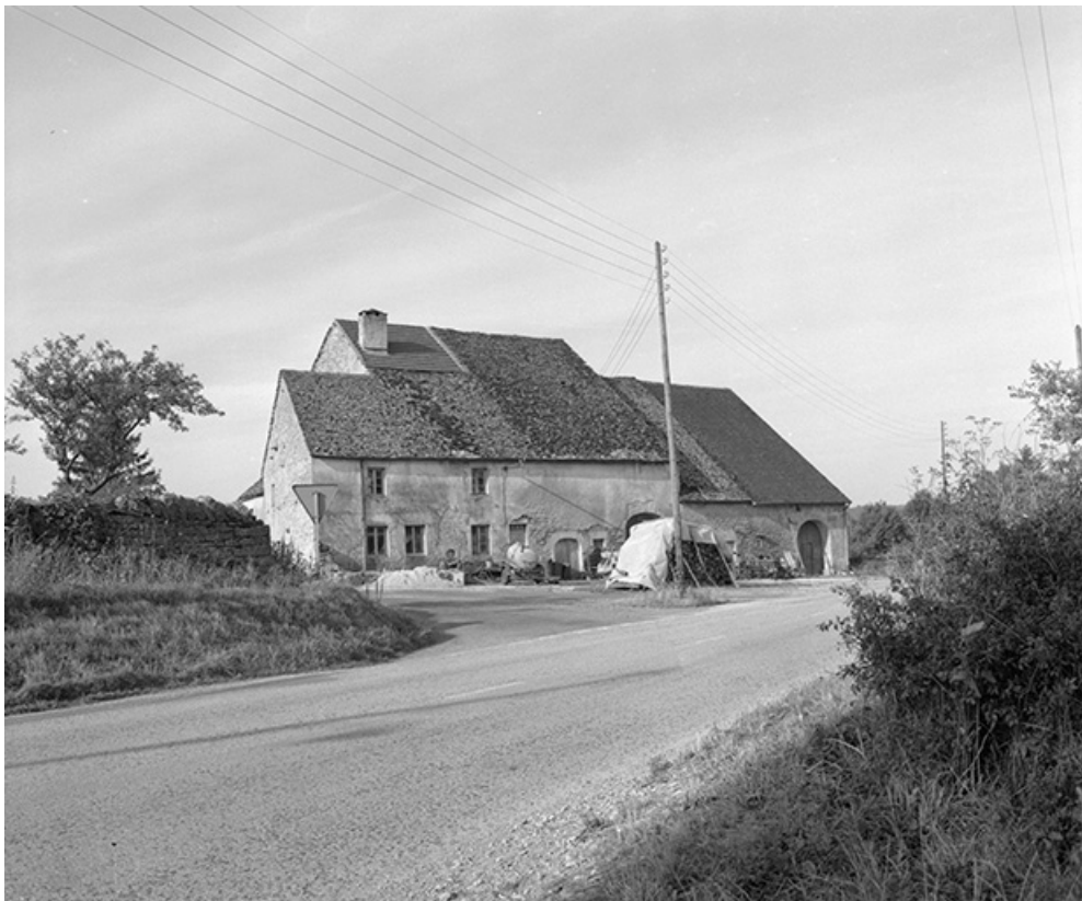
Façade antérieure : vue éloignée.
