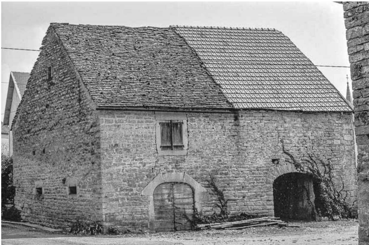
Ferme cadastrée 1951 E1 93 : bâtiment agricole. 39, Crançot
