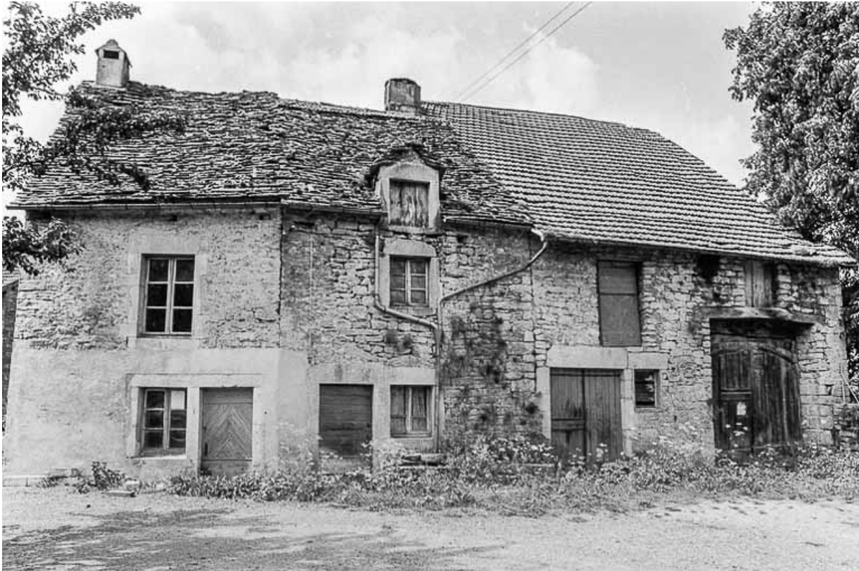
Ferme cadastrée 1951 E1 76 : façade antérieure. 39, Crançot
