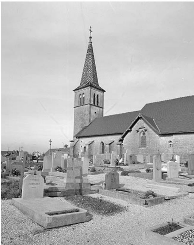
Extérieur : face latérale droite, partie gauche.
