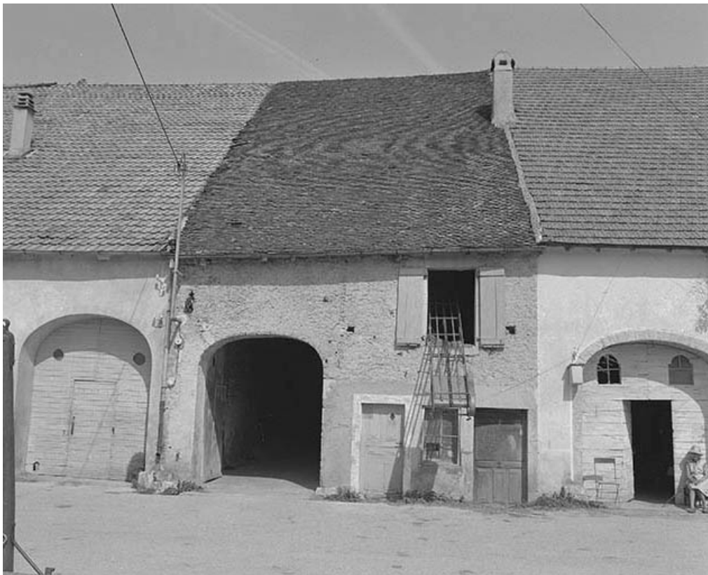
Façade antérieure, de face.
