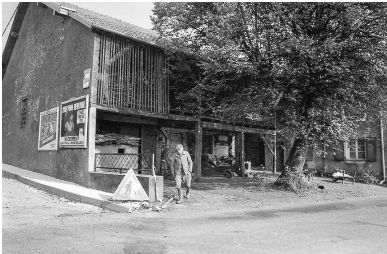
Façade antérieure : détail.
