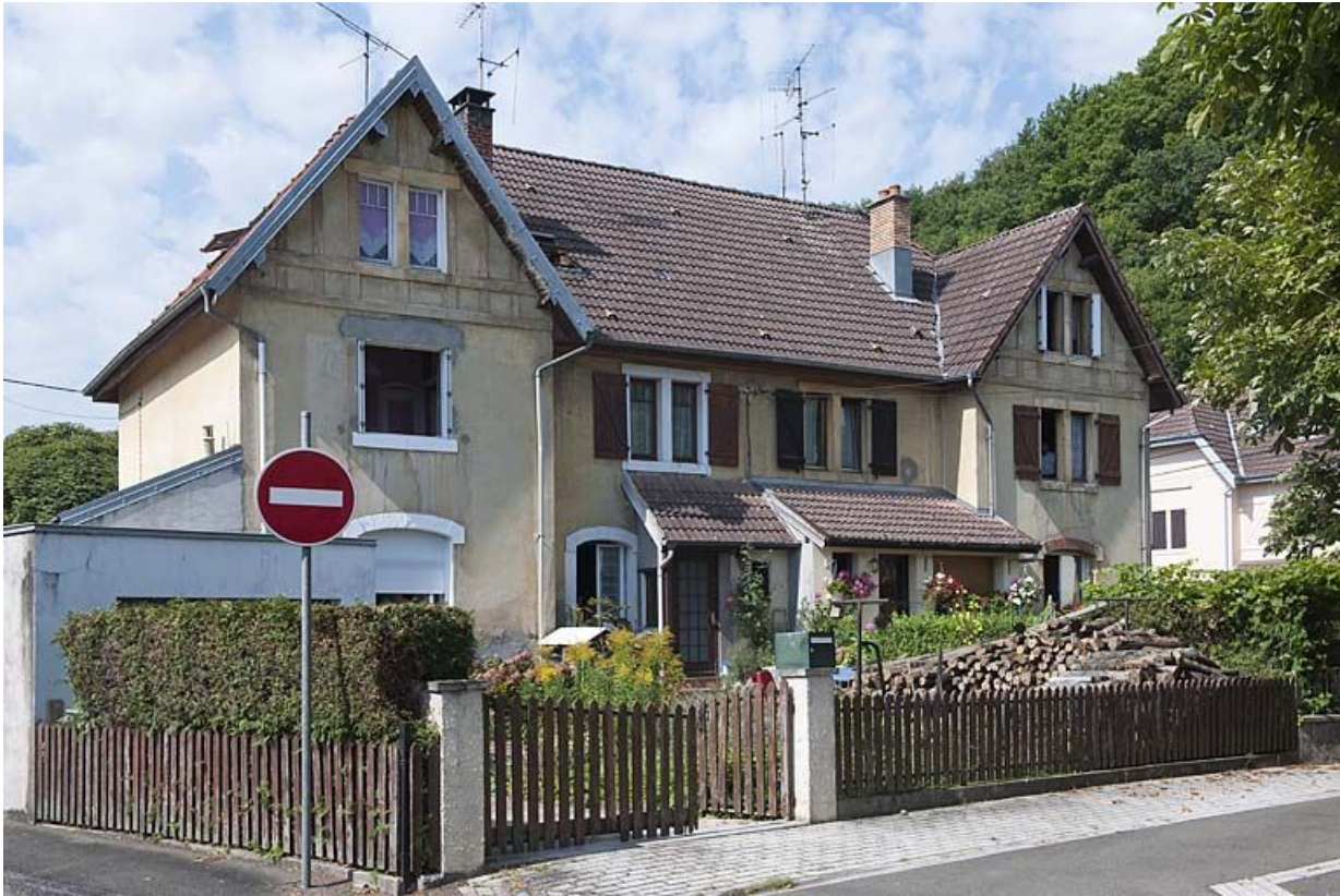
Habitation à 4 logements. Façade antérieure.
