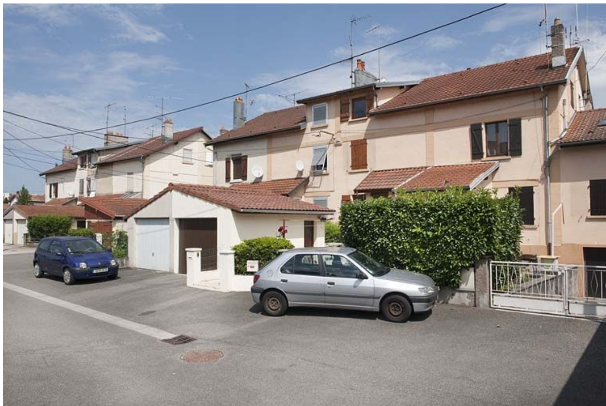
Habitations à 8 logements. Vue de trois quarts.
