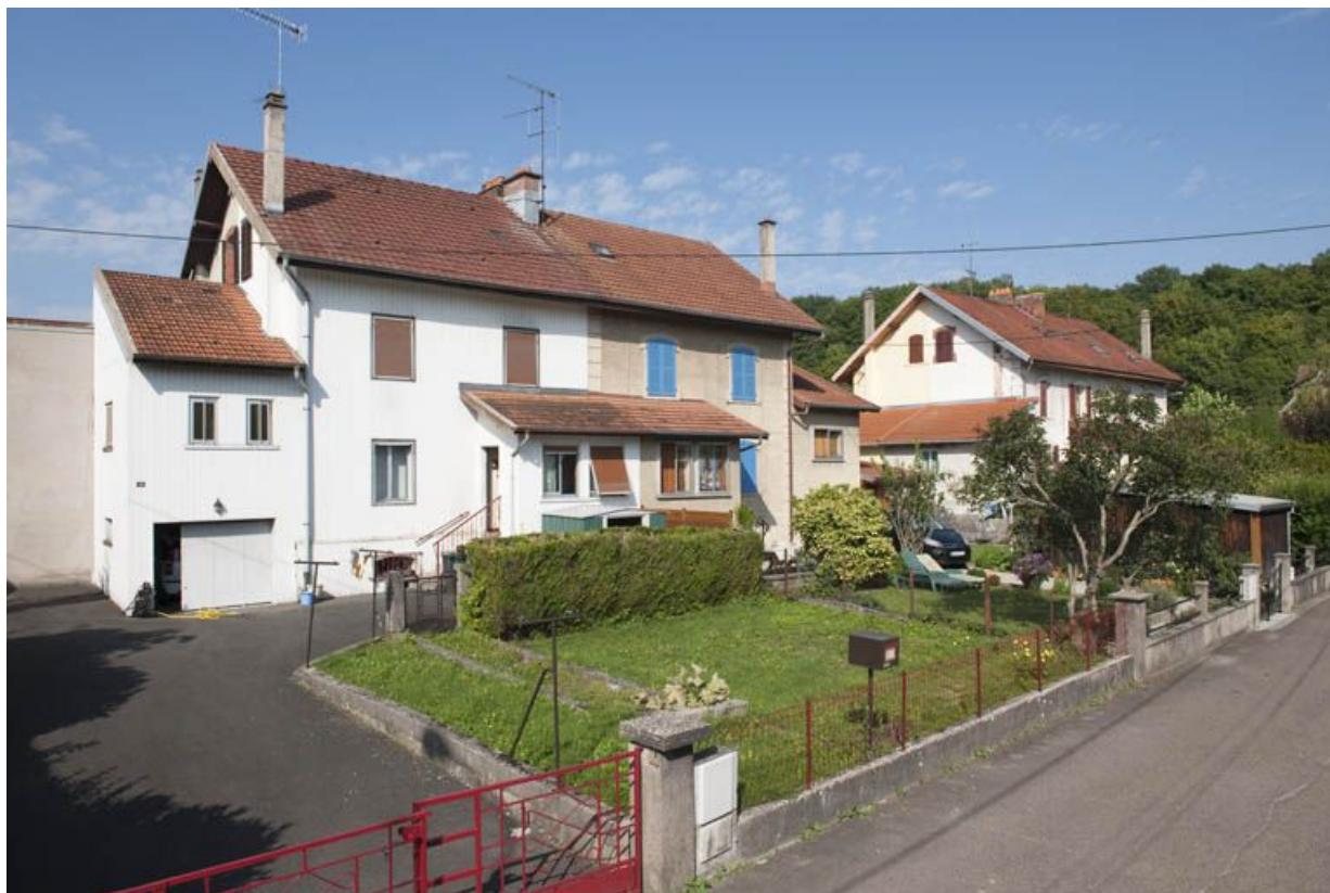
Habitations à 4 logements vues de trois quarts.
