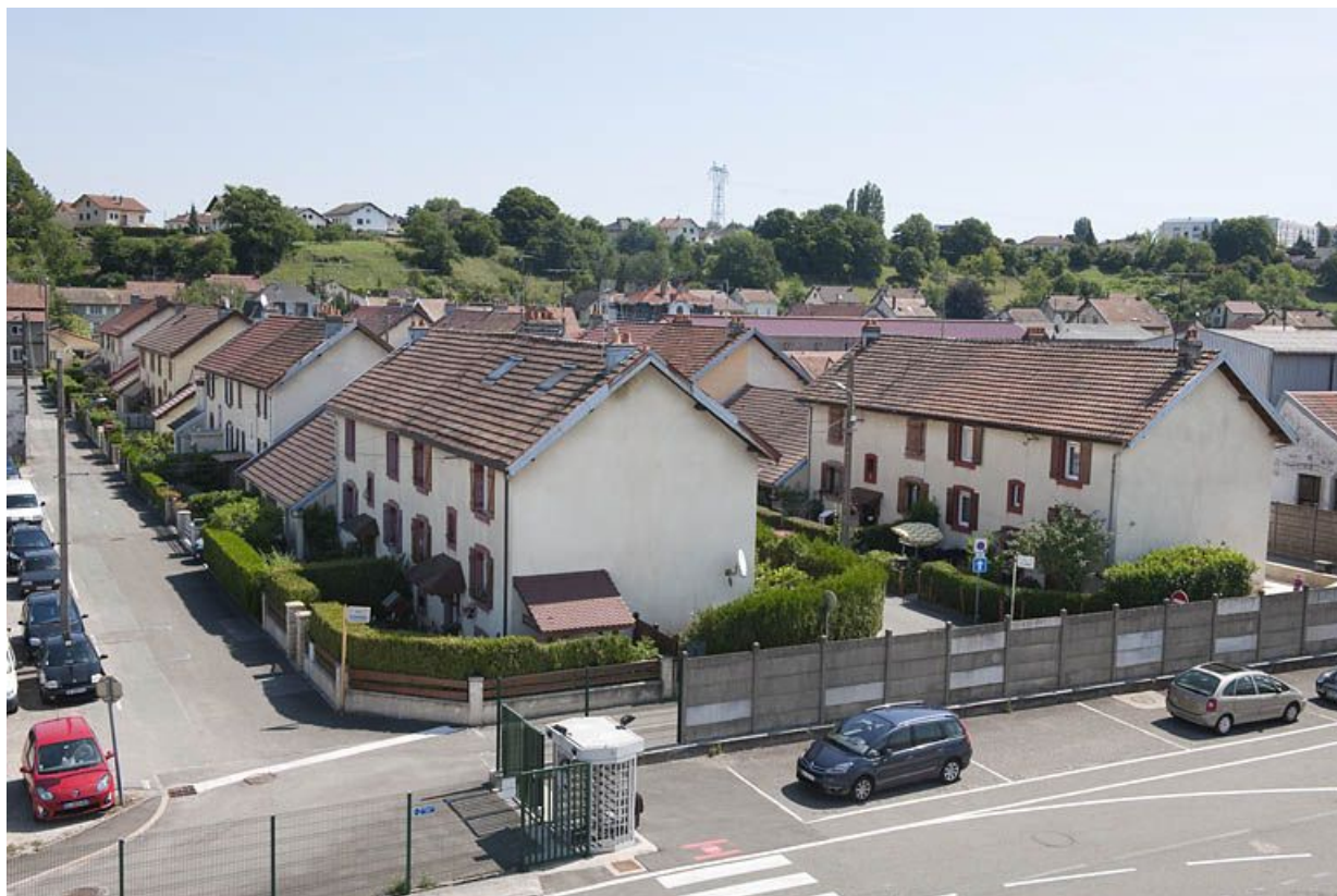
Vue plongeante depuis l'ouest.
