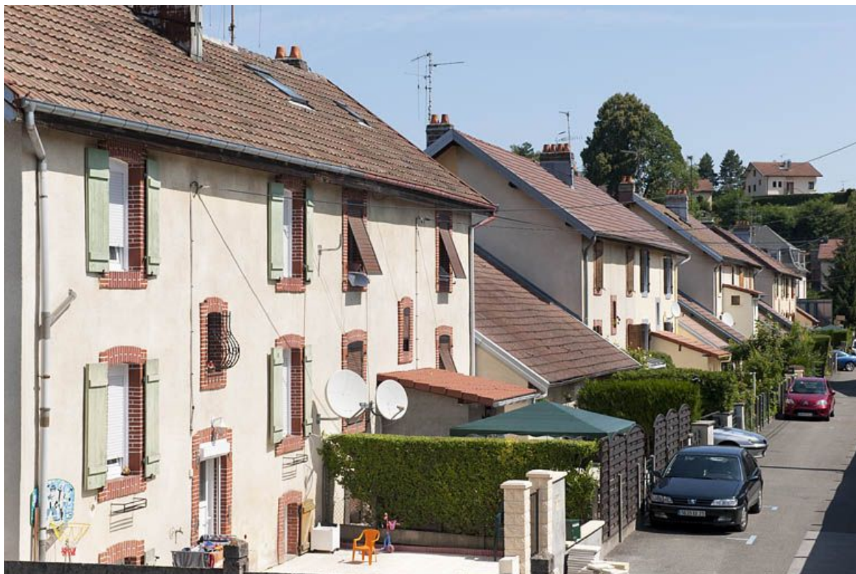
Vue d'ensemble des maisons rue de Reims.
