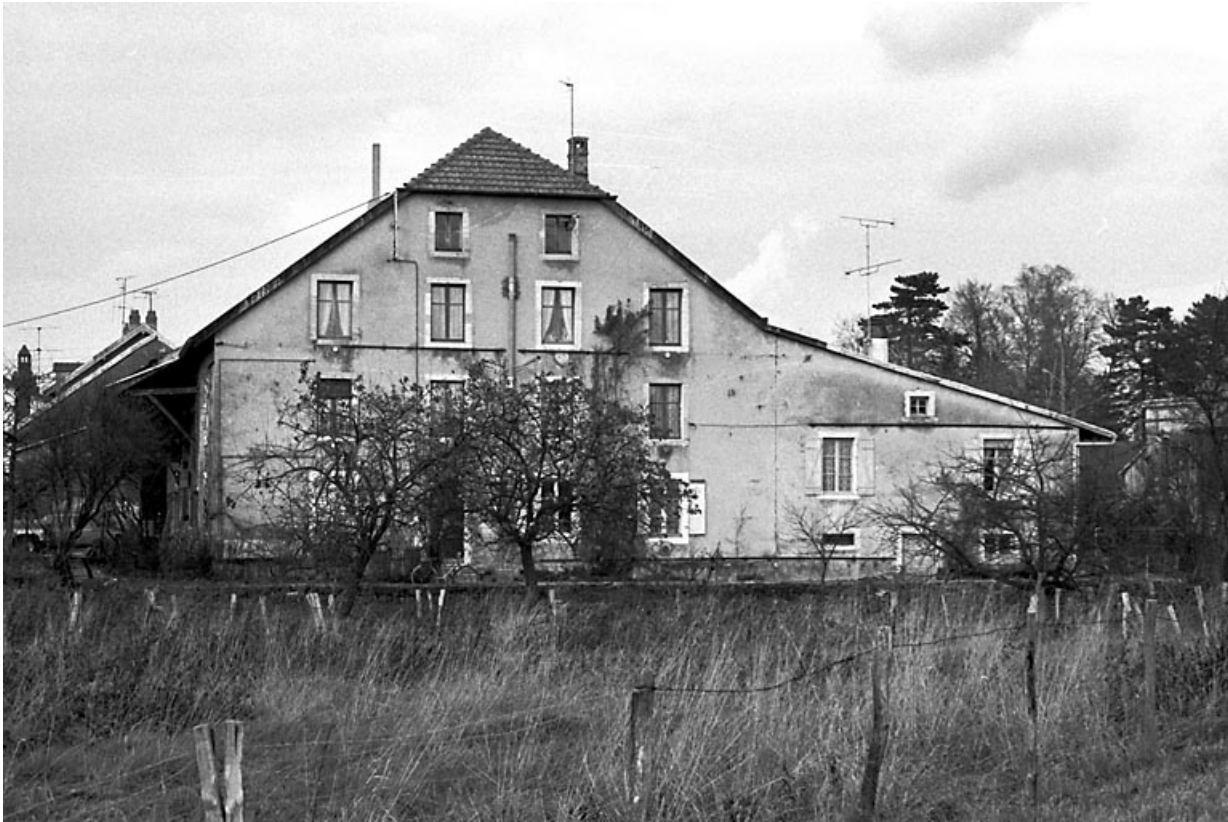
Vue du pignon droit de l'habitation.
