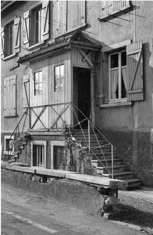
Détail de l'élévation antérieure.
