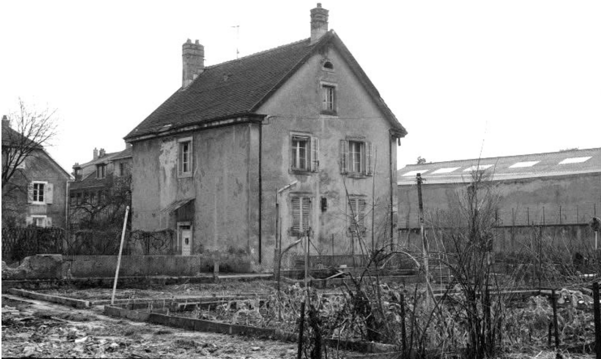
Façades postérieure et latérale gauche.
