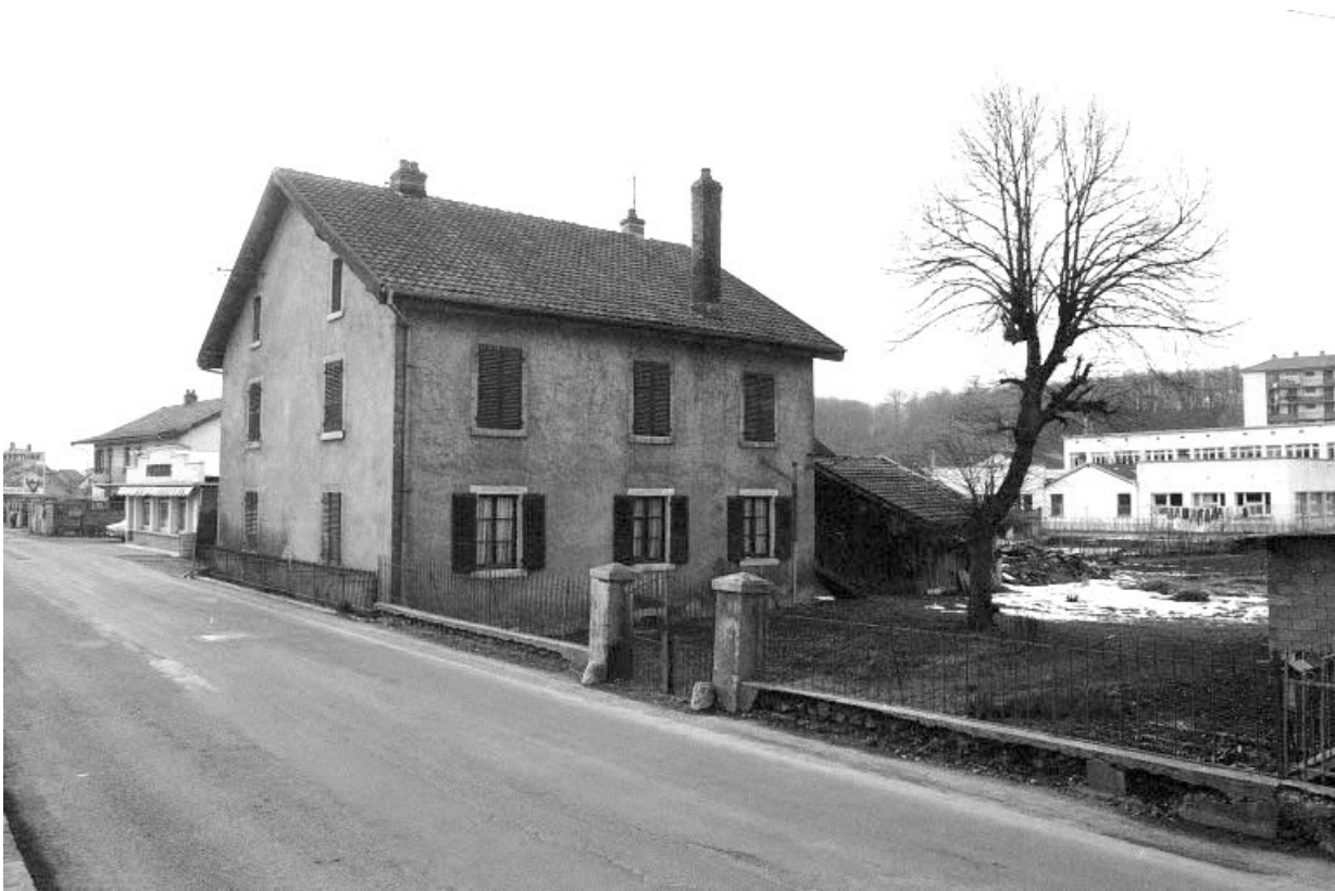
Façades postérieure et latérale droite.
