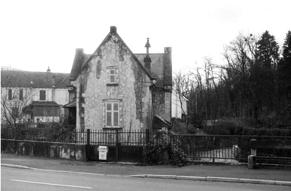
Façade latérale gauche. 25, Audincourt, 68 rue de Valentigney
