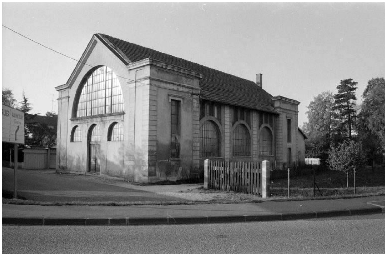
Façades antérieure et latérale droite.
