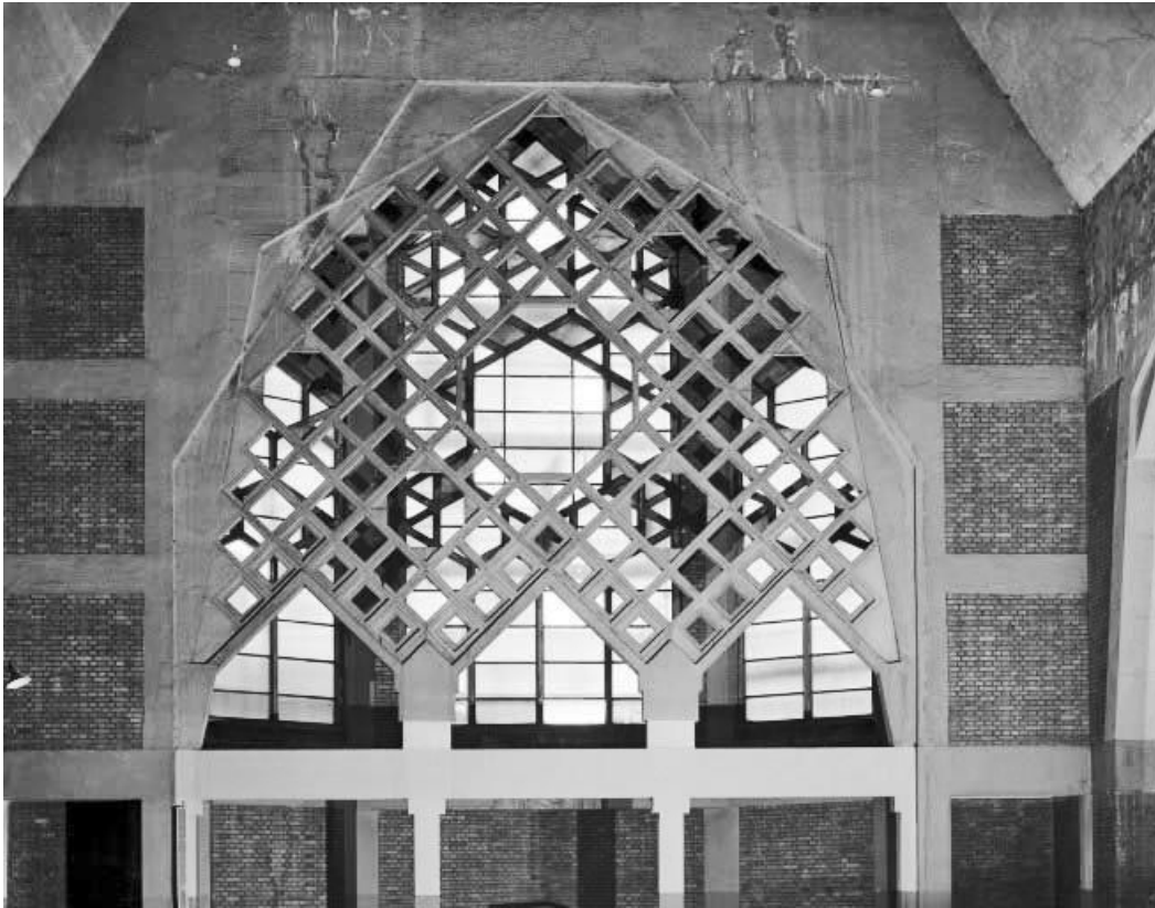
Bras gauche du transept.
