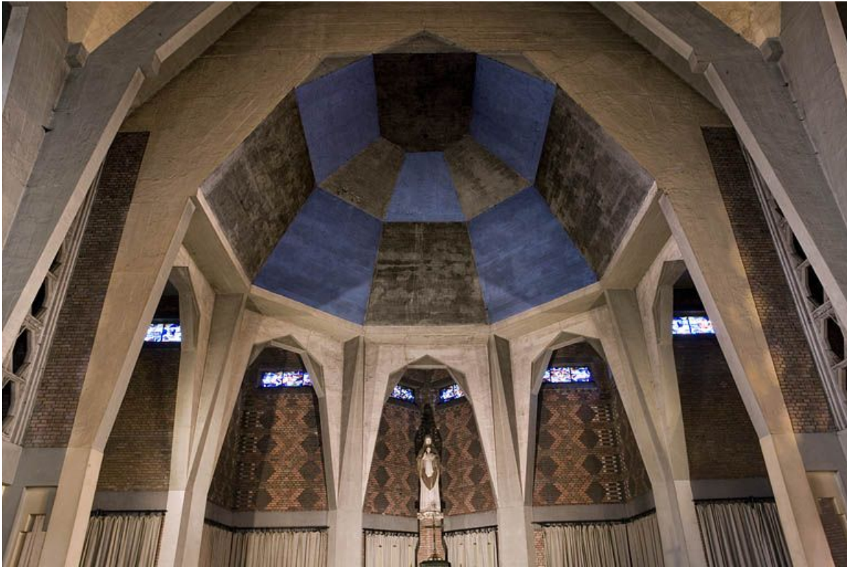
Plafond et piliers du chœur.
