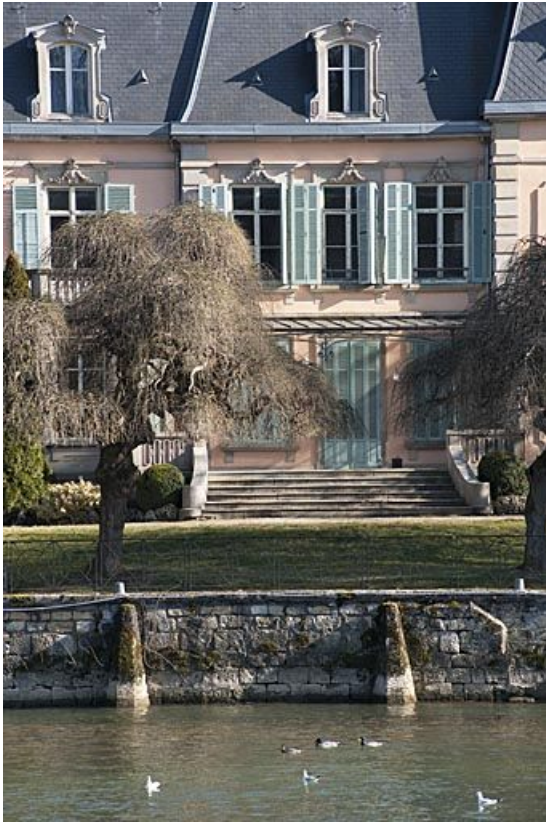
Détail de la façade ouest.
